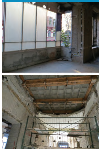
Az ambulancia az építkezés alatt
